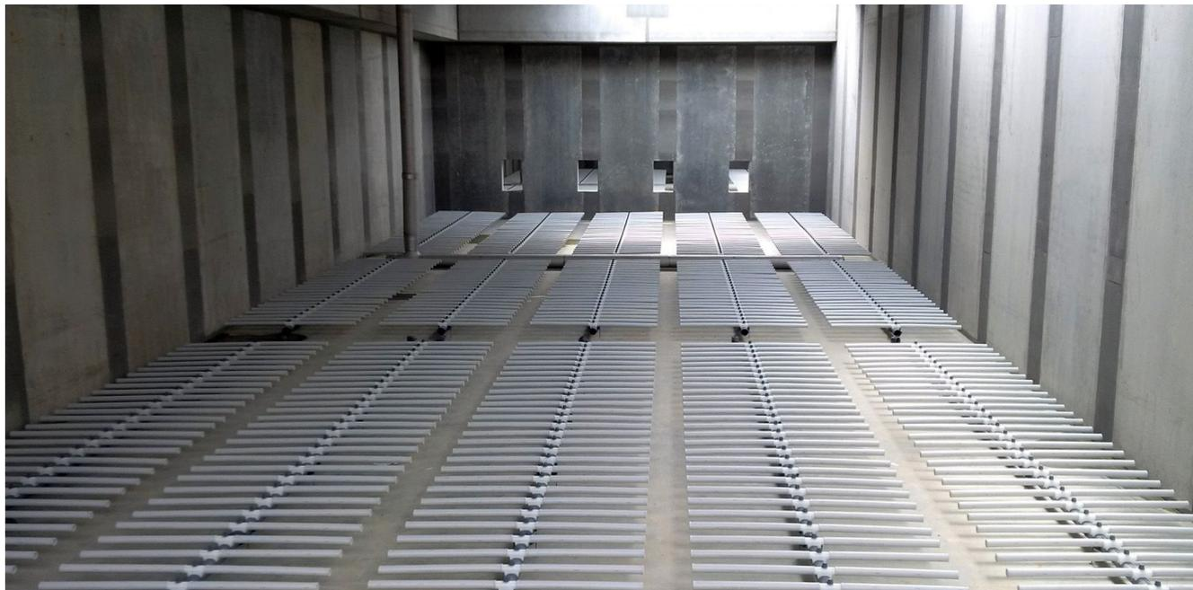
AirRex パイピングシステムは、モジュール式で、プレハブ構造で、アンカーロッドなどの固定部品が完備されています。据付式のステンレス鋼製ディフューザーグリッドに対して競争力を持つ代替システムです。
