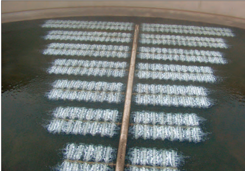
DIE MEMBRANROHRBELÜFTER VON OTT SORGEN FÜR EINE FEINBLASIGE BELÜFTUNG.
